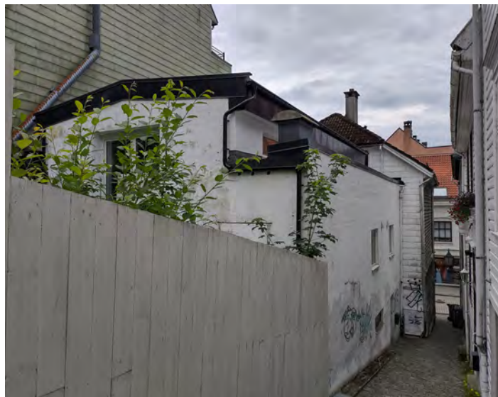
BILDE: Lindebergsmauet 1 i dag sett mot ned mot Øvregaten. Smauene er typisk for Bergen og er en del av den verneverdige bystrukturen.
