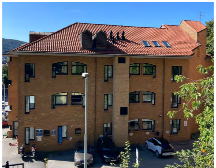
BILDE: Heggbakken 2 sett fra øverst i gateløpet, mot Cappes vei.
