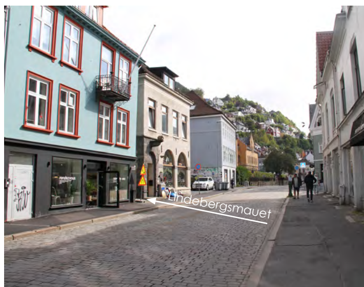
BILDE: Øvregaten 11 sett sammen med Øvregaten 13 og 7. Mellom Øvregaten 11 og 13 kommer man opp til Lindebergsmauet.
