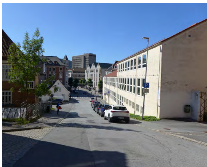
BILDE: Kong Oscars gate 36 Sett i sammenheng med gateløpet og Heggebakken 1.
